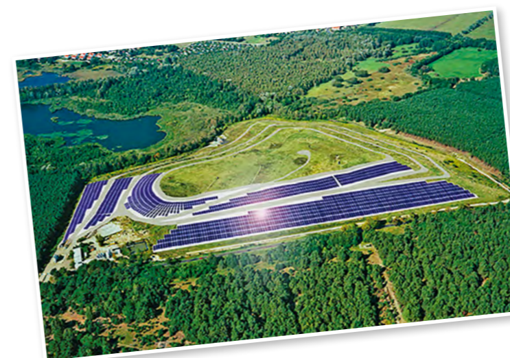
Photovoltaikanlage an der Deponie Wernsdorf (Montage)
