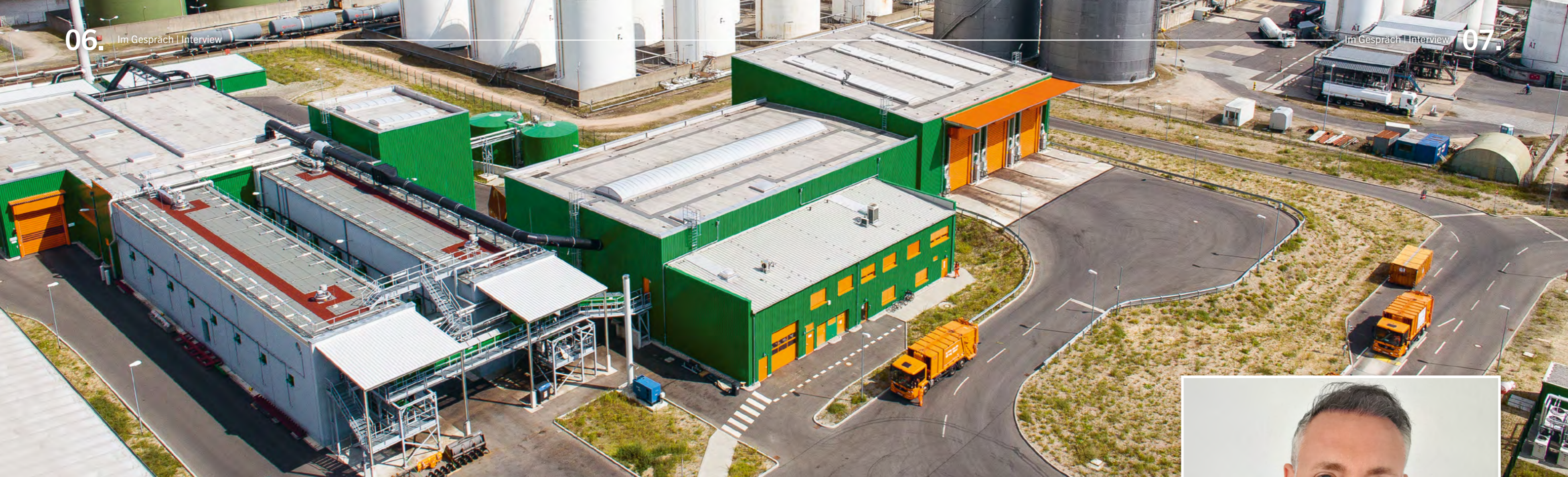
BSR-Biogasanlage in Ruhleben
